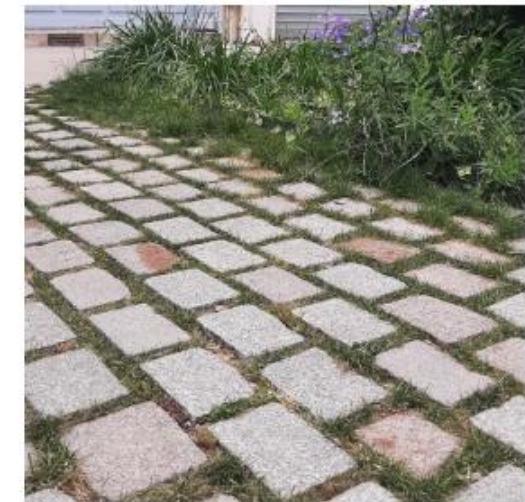
Désimperméabiliser la voirie : les pavés perméables (enherbés, à larges joints, en béton perméable, ...)
